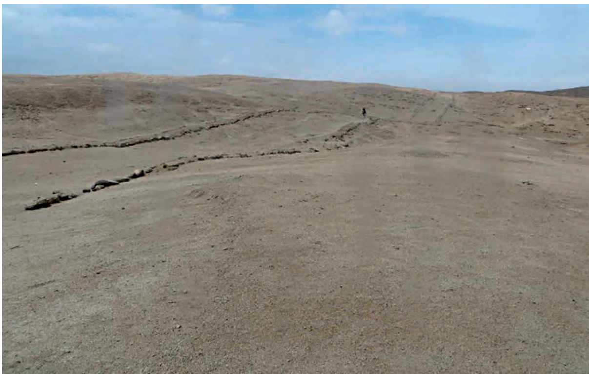
Figura 7. Segmento del camino con muros laterales que se adapta a un terreno sinuoso en el sector de pampa Antival.
